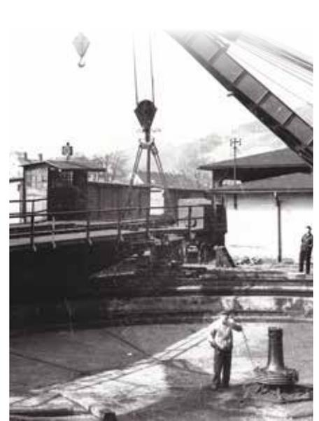
● Ein Meilenstein für das SÜDBAHN Museum ist die Komplettrestaurierung der Drehscheibe. Im November 2021 begannen die Arbeiten mit dem Aushub der ungefähr 34 Tonnen schweren Brücke. Über die Wintermonate wurde am Korrosionsschutz der Stahlkonstruktion gearbeitet. Das Betonfundament ist im Frühjahr 2022 saniert worden, ebenso das zentrale mechanische Element unserer Drehscheibe der sogenannte Königsstuhl.
