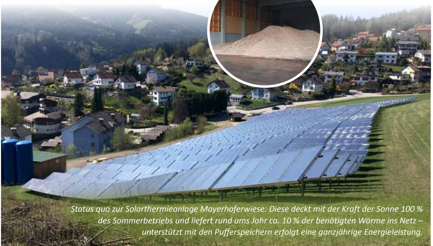
*Status quo zur Solarthermieanlage Mayerhoferwiese: Diese deckt mit der Kraft der Sonne 100 % des Sommerbetriebs und liefert rund ums Jahr ca. 10 % der benötigten Wärme ins Netz – unterstützt mit den Pufferspeichern erfolgt eine ganzjährige Energieleistung.*
