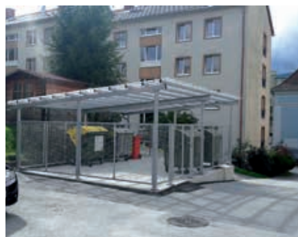
Errichtung von Müllplatzüberdachungen
