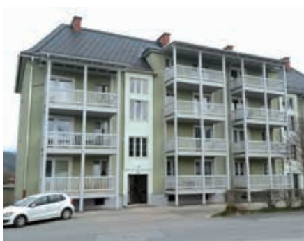
Neue Balkone in der Schulstraße
