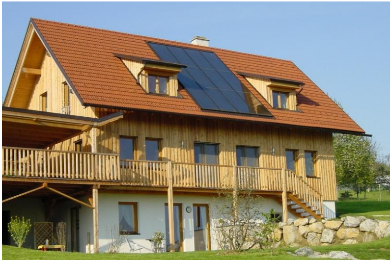
Niedrigenergiehaus mit teilsolarer Raumheizungsunterstützung
